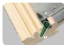
① Новый метод крепления оконных петель: применение усиленных саморезов большего диаметра, вкрученных под углом в деревянные элементы створки, предотвращает вырывание петель и возможность выдавливания створки.
